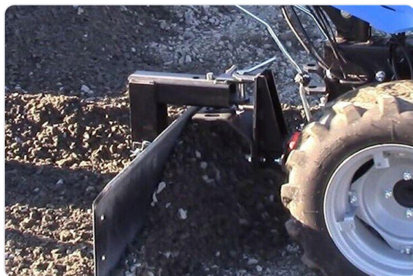
NIVELANDO GRAVA EN CAMPO
